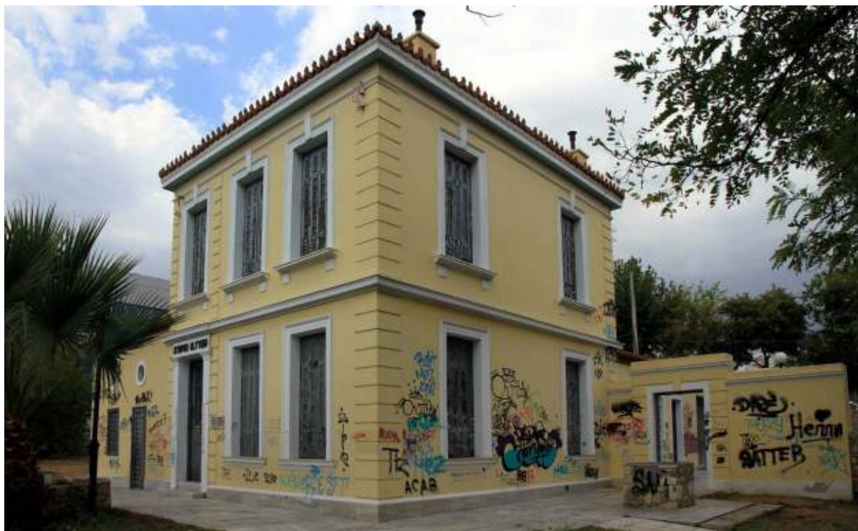
Νοτιοανατολική άποψη του κτιρίου. Είναι εμφανείς οι «βανδαλισμοί» που έχει υποστεί.
