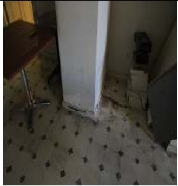
Ανοδικές υγρασίες υπογείου
