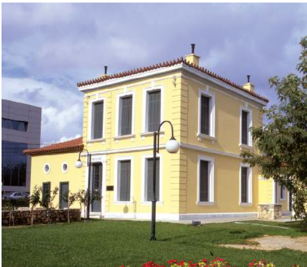
Άποψη του κτιρίου το 2006, μετά την αποκατάστασή του.
