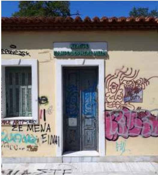
Λεπτομέρεια της ανατολικής όψης. Τα κούφωματα χρειάζονται συντήρηση και αποκατάσταση και η κακότεχνη επιγραφή στο υπέρθυρο αποξήλωση.
