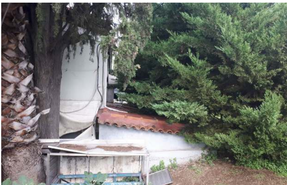
Άποψη του κτιρίου από βορειοανατολικά
