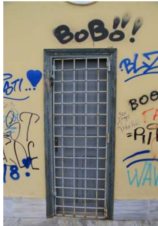
Άποψη της εισόδου της αίθουσας Ν. Γύζη. Χρειάζεται αποξήλωση του νεωτερικού κιγκλιδώματος και ανακατασκευή της θύρας με προδιαγραφές ασφαλείας.
