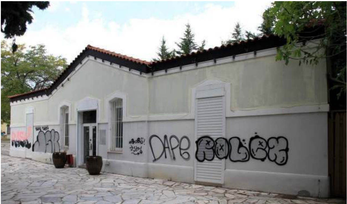
Άποψη της Νότιας όψης του κτιρίου των Στάβλων
