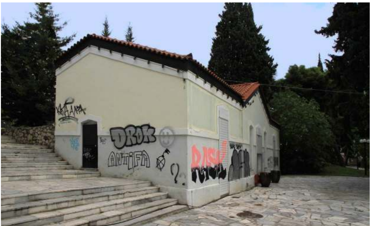
Άποψη του κτιρίου των Στάβλων από Νοτιοδυτικά
