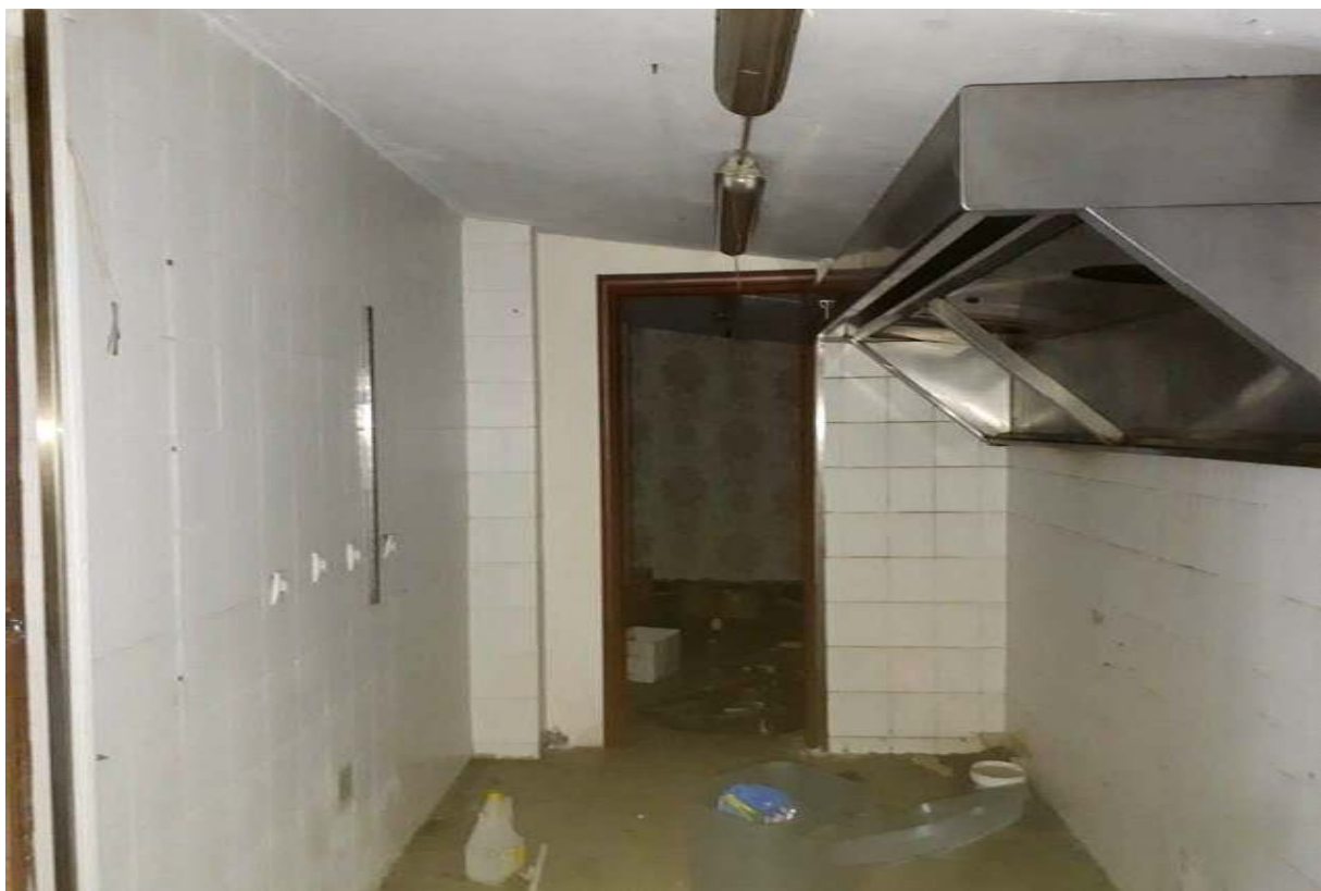
Άποψη του εσωτερικού χώρου της βόρειας προσθήκης του κτιρίου
