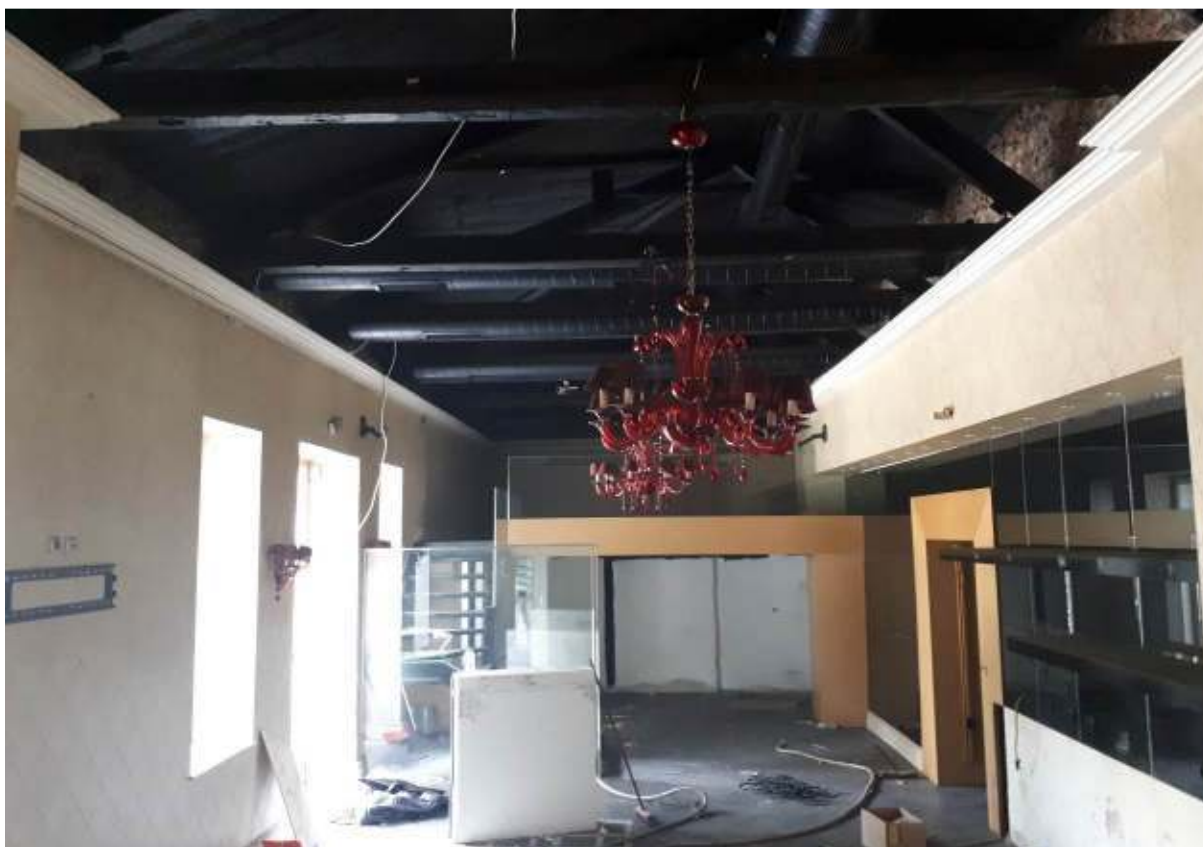
Άποψη του κεντρικού εσωτερικού χώρου του κτιρίου
