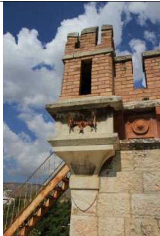
Επάλξεις και ελκυστήρες δώματος
