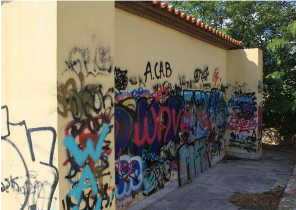
Άποψη της βόρειας πλευράς του ισογείου τμήματος κτιρίου.
