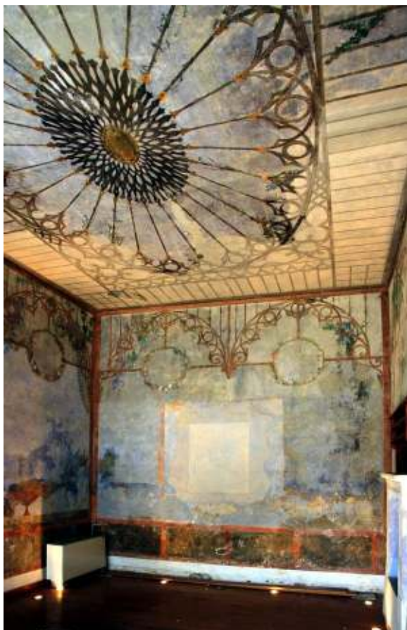
Αίθουσα Ν. Γύζη. Άποψη του βορείου τοίχου, που παρουσιάζει τις σημαντικότερες φθορές, λόγω υγρασιών. Απαιτείται συντήρηση και αποκατάσταση των τοιχογραφιών, του δαπέδου και της οροφograφίας.
